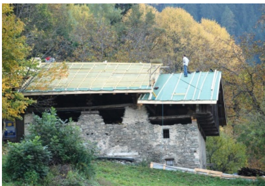
Pose du sarking sur le chalet. Photo P. et A. Hoogewys © Prix René Fontaine, Catégorie bâti contemporain, 2015.
