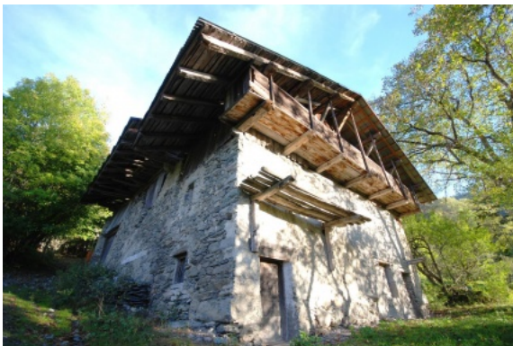
Vue du chalet d'alpage avant les travaux. Photo P. et A. Hoogewys © Prix René Fontaine, Catégorie bâti
