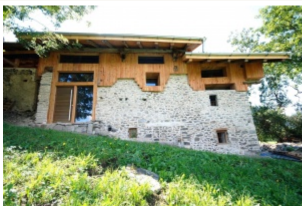
Chalet d'alpage, état après travaux.
