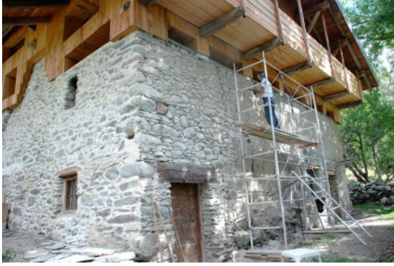
Piquetage de l'enduit des murs. Photo P. et A. Hoogewys © Prix René Fontaine, Catégorie bâti contemporain, 2015.
