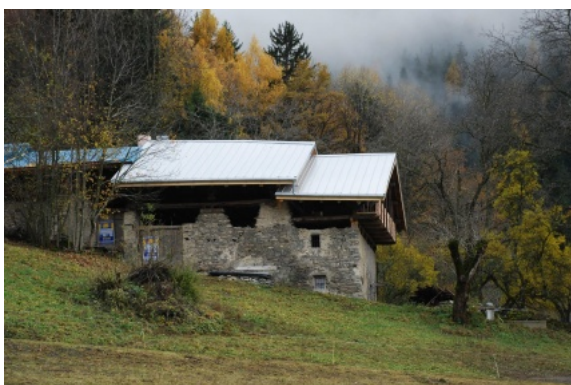
Toit après la pose du sarking. Photo P. et A. Hoogewys © Prix René Fontaine, Catégorie bâti contemporain, 2015.
