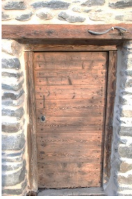
Restauration d'une porte en bois existante. Photo P. et A. Hoogewys © Prix René Fontaine, Catégorie bâti contemporain, 2015.
