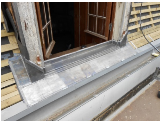
Appui de fenêtre en plomb et liteaunage restaurés. Photo Pierre Danielczak © Prix René Fontaine 2018.
