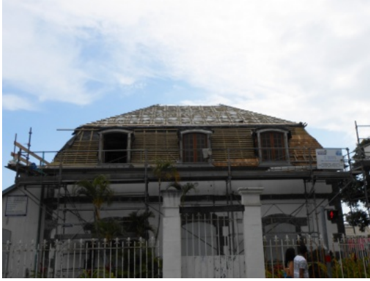
Restauration du liteaunage avant pose de bardeaux. Photo Pierre Danielczak © Prix René Fontaine 2018.
