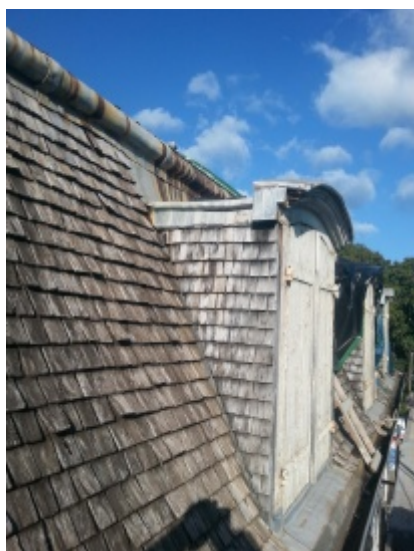
Toit couvert de bardeaux de bois de tamarin avant restauration. Photo Pierre Danielczak © Prix René Fontaine 2018.
