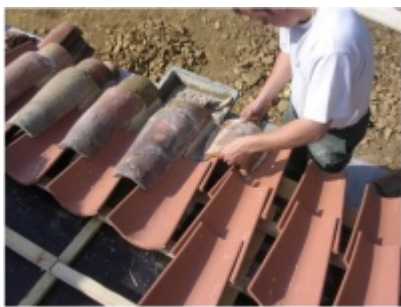
Pose tuile canal © Pierre Forissier
