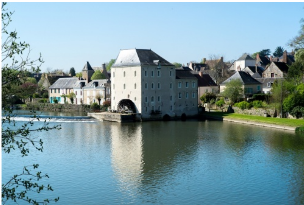
Le moulin en 2017 après restauration.
