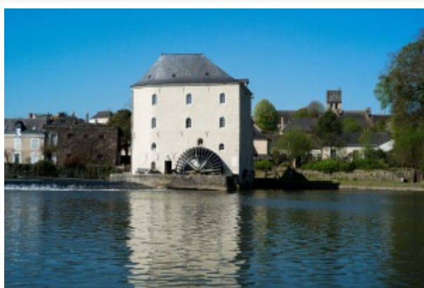
Façade est restaurée.
