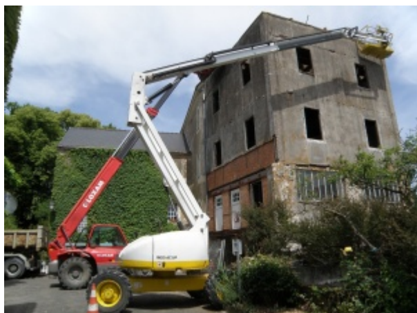
Démolition de l'annexe formant verrue en 2012 - Photo Isabelle Chiaramonti-Monnet ©
