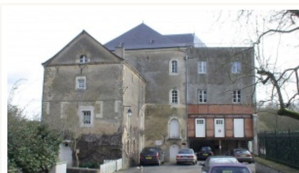
Façade ouest (côté village) en 2010 avant travaux.
