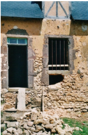
Etat avant travaux sous la lucarne principale : la porte d'origine va être repositionnée après percement de la baie en partie basse. La porte de gauche est transformée en fenêtre. Photo Gérard Gasnier © Maisons Paysannes de France, Prix René Fontaine.
