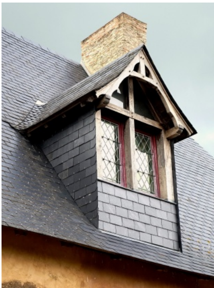
La lucarne restaurée. Photo Gérard Gasnier © Maisons Paysannes de France, délégation de la Sarthe.
