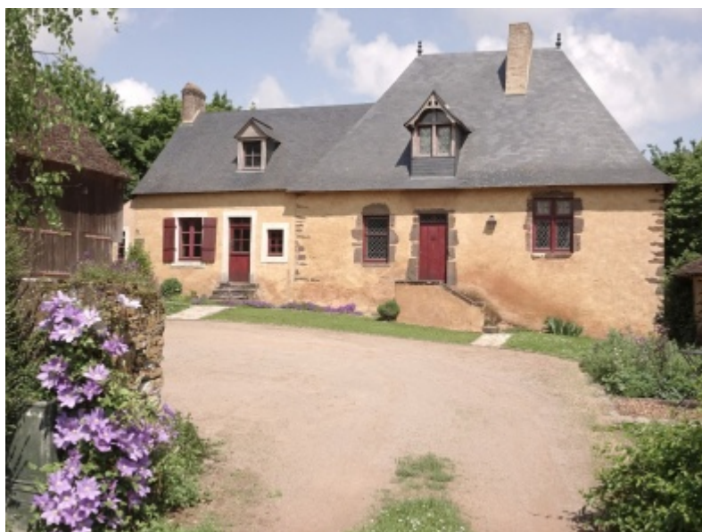
Le logis vu depuis la cour.
