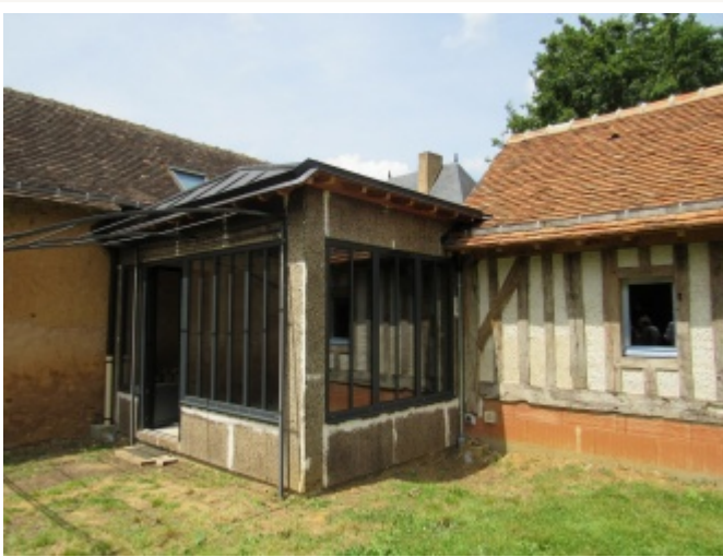
L'extension en cours de travaux.
