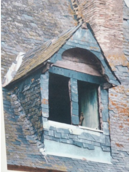
Lucarne principale avant travaux (Les Hayes). Photo Gérard Gasnier © Maisons Paysannes de France, Prix René Fontaine.
