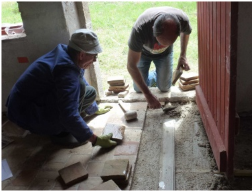
Pose des carreaux à joints décalés. Le carreau est mouillé pour plus d'adhérence. Photo Maisons Paysannes de France © Délégation du Loiret.
