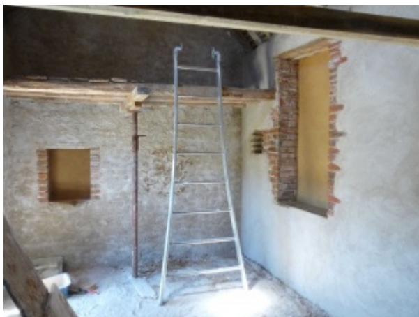
Sur le mur du fond, du corps d'enduit. Sur le mur de droite, enduit de finition.
