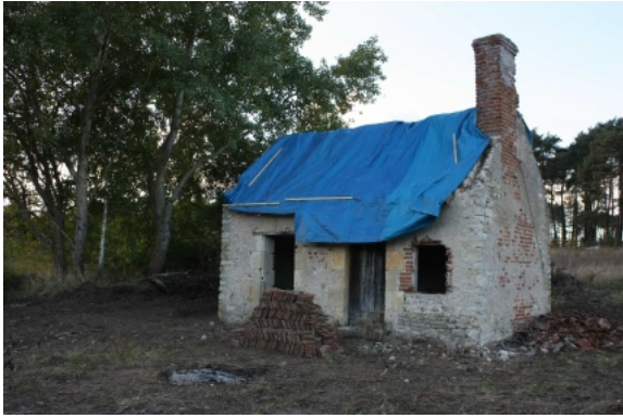
Dépose des tuiles et toit bâché. Photo Claudie Plisson, Maisons Paysannes de France © Délégation du Loiret.
