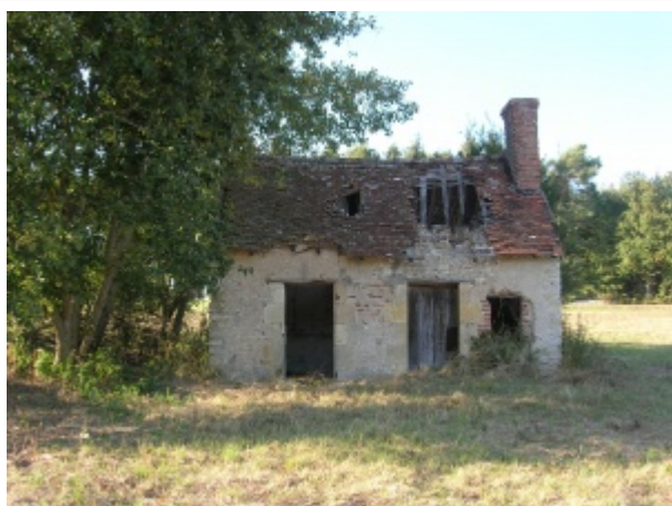
La loge de vigne avant travaux de restauration, Mardié (45).
