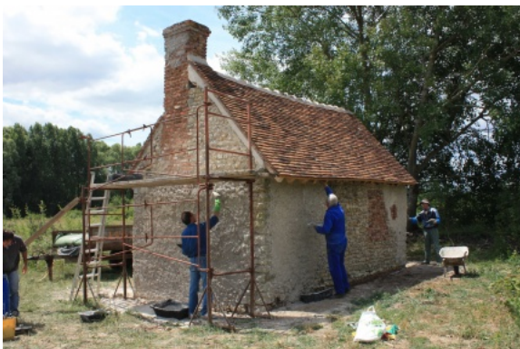
Pose du dégrossi. Photo Claudie Plisson © Maisons Paysannes de France, Délégation du Loiret.
