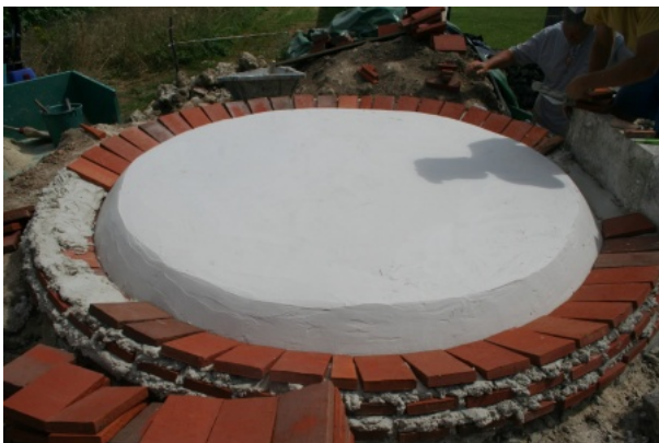
Pose des briques autour du coffrage. Photo Maisons Paysannes de France, Délégation Dordogne-Périgord ©
