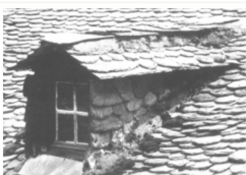
Faîtage à plat sur une lucarne
