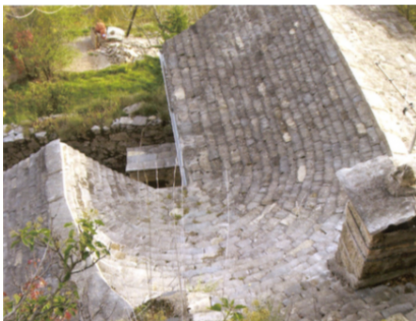
Toiture en noue, village du Capluc Photo Alain Alexandre ©
