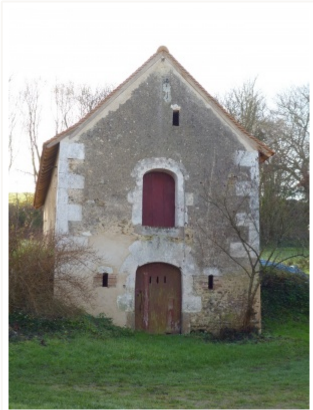
Pignon avec chaînage en pierre de taille - Photo F. Pasquier - Maisons Paysannes de la Sarthe.
