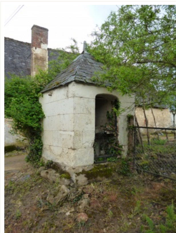
Puits carré en tuffeau - Photo F. Pasquier - Maisons Paysannes de la Sarthe.
