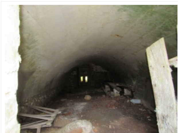
Cave voûtée de tuffeau - Photo F. Pasquier - Maisons Paysannes de la Sarthe.
