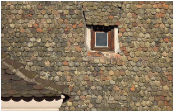
Couverture à pose classique, Strasbourg
