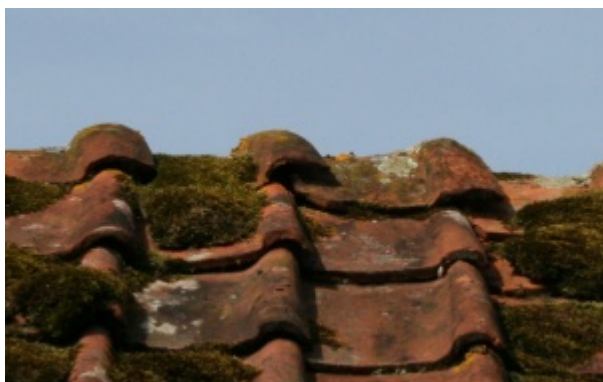
Pannes faîtières à recouvrement 1 largeur, situées à Béhancourt.
