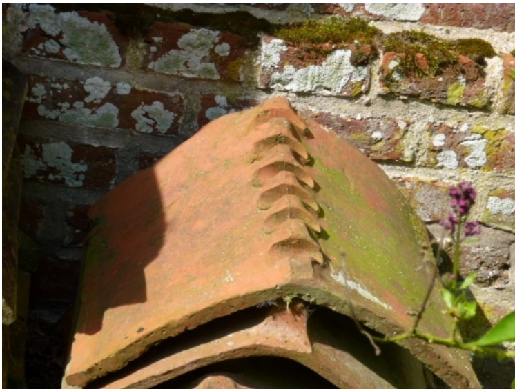
Panne faîtière à crête, située à Montigny sur l'Hallue, 2014. Photo Maisons Paysannes de France, délégation de la Somme ©.
