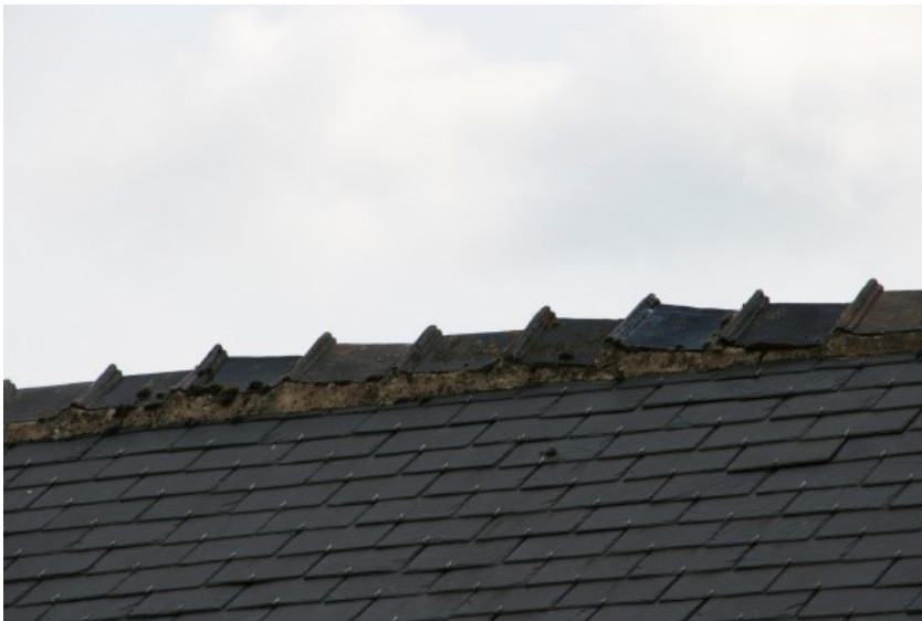
Photo d'une faîtière vernissée en V sur couverture d'ardoises, située à Pont de Metz (80).
