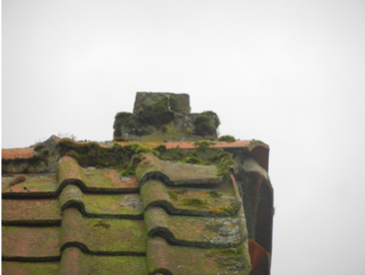
Briques posées en épi de faîtage. Photo Nicole Dupré © Maisons Paysannes de France, Délégation de la Somme.
