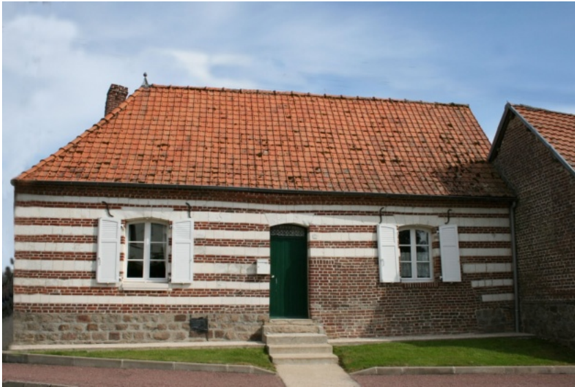
Maison couverte de tuiles industrielles type Monopole dont les pannes faîtières recouvrent 3 rangs de pannes, situé à Rubempré. Photo Jean-François Herlem © Maisons Paysannes de France, Délégation de la Somme.
