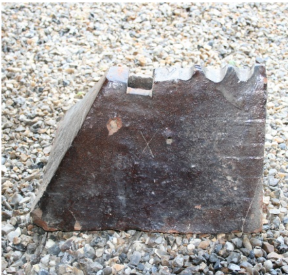
Tuile faîtière terminale en V vernissée pour toit avec arêtières et trou pour épi de faîtage. Vue de côté. Photo Jean-François Herlem © Maisons Paysannes de France, Délégation de la Somme.
