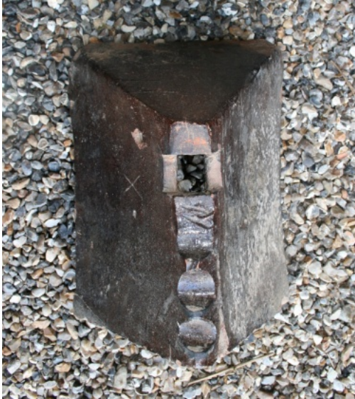
Tuile faîtière terminale en V vernissée pour toit avec arêtières et trou pour épi de faîtage. Photo Jean-François Herlem © Maisons Paysannes de France, Délégation de la Somme.
